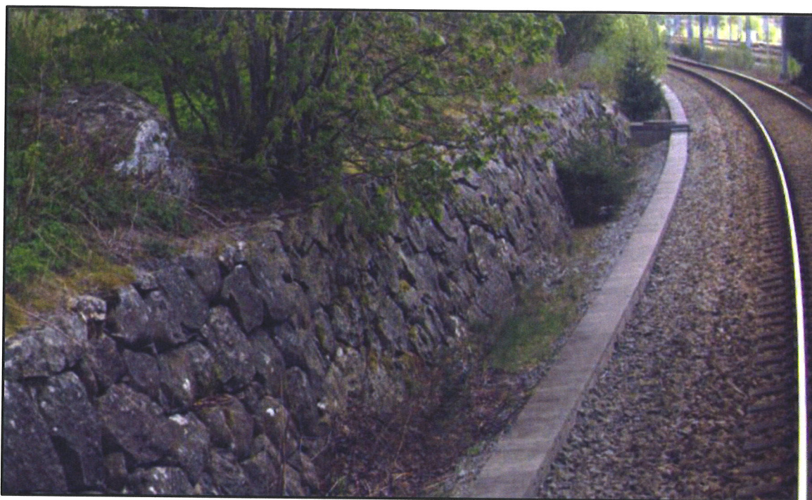
Figur 79 Dagens løsning med tørrmur av naturstein i bunnen av løsmasseskjæring på østlig side av spor (km. 578,660). Bilde i sørlig retning. Kilde: Målevognsbilde (mot Oslo).
