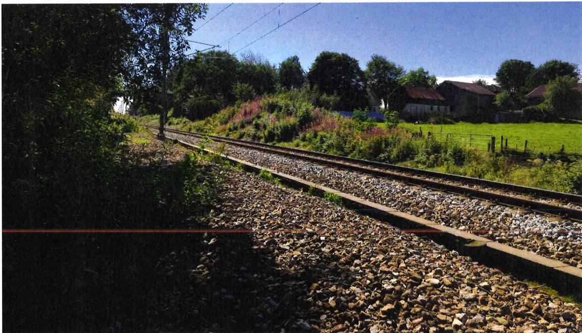
Figur 60 Bilde av sporet som viser hvordan det ligger i dagens terreng.
