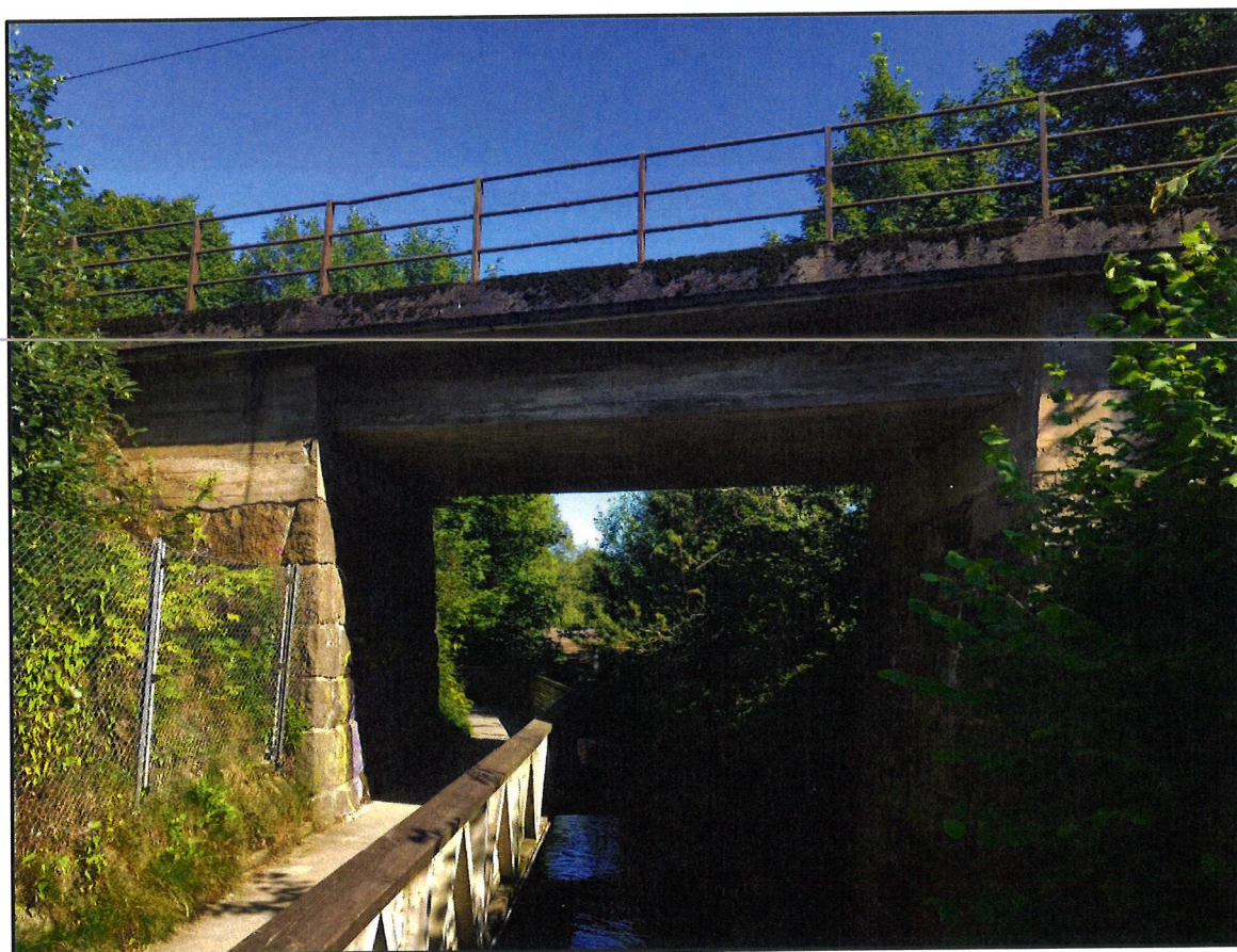
Figur 43 Konstruksjon ved dagens kryssing med Bryneåna (km. 569,566). Bilde i østlig retning. Kilde: Jakob Bitsch Jensen (befaring 2020-08-06).
