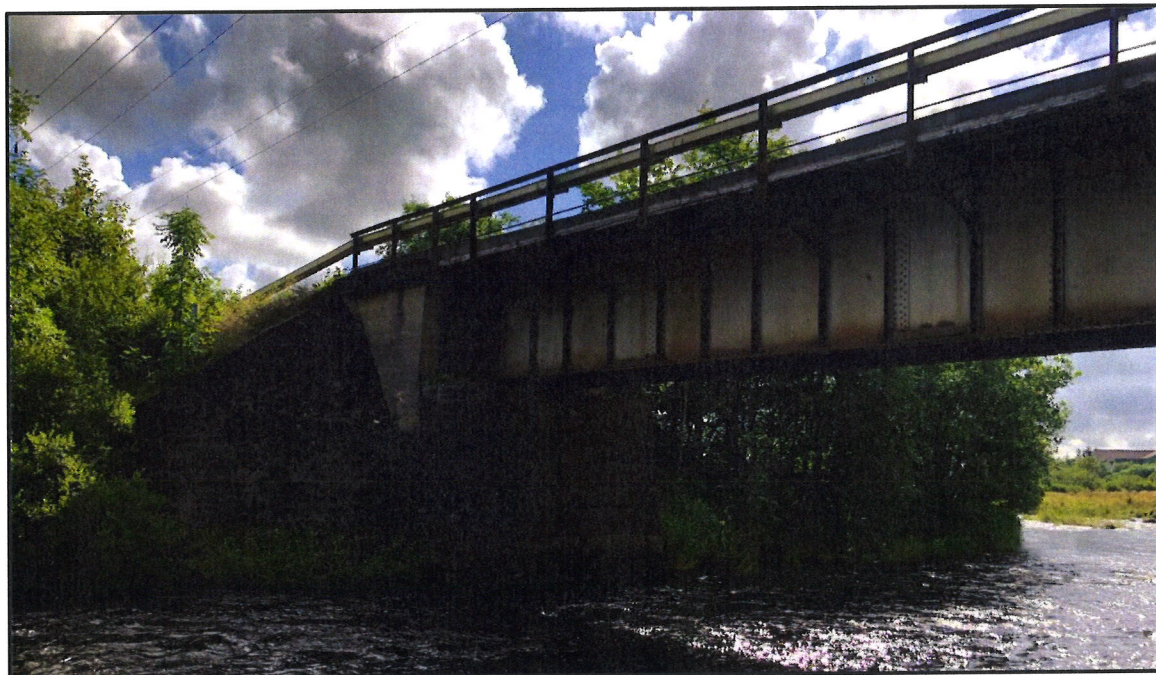
Figur 32 Sørlig landkar for konstruksjon ved dagens kryssing med Hååna (km. 564,747). Bilde i sør-vestlig retning. Kilde: Jakob Bitsch Jensen (befaring 2020-08-04).
