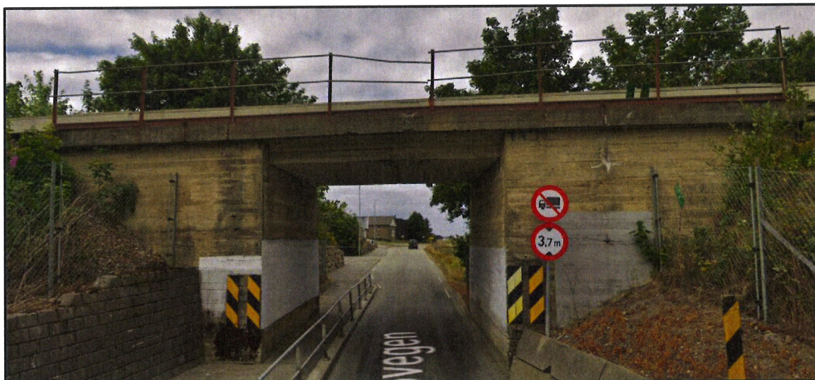
Figur 29 Konstruksjon ved dagens kryssing med Bøvegen (km. 562,250). Bilde i vestlig retning. Kilde: Google Streetview (2018).
