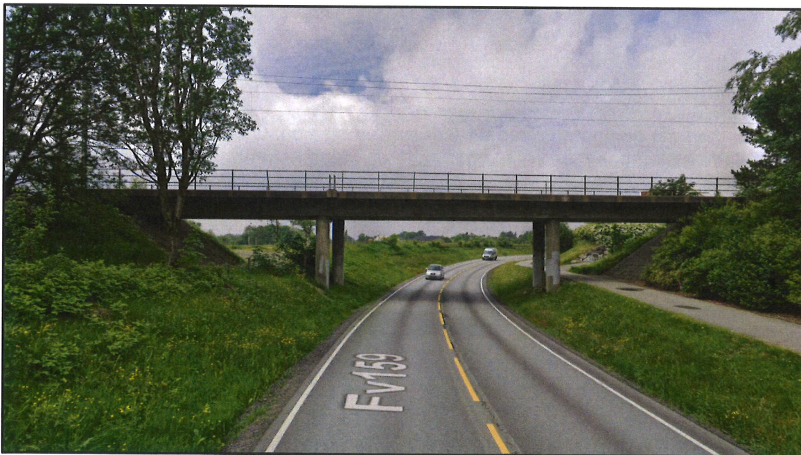
Figur 18 Konstruksjon ved dagens kryssing med Store ring (km. 560,377). Bilde i vestlig retning. Kilde: Google Streetview (2019)
