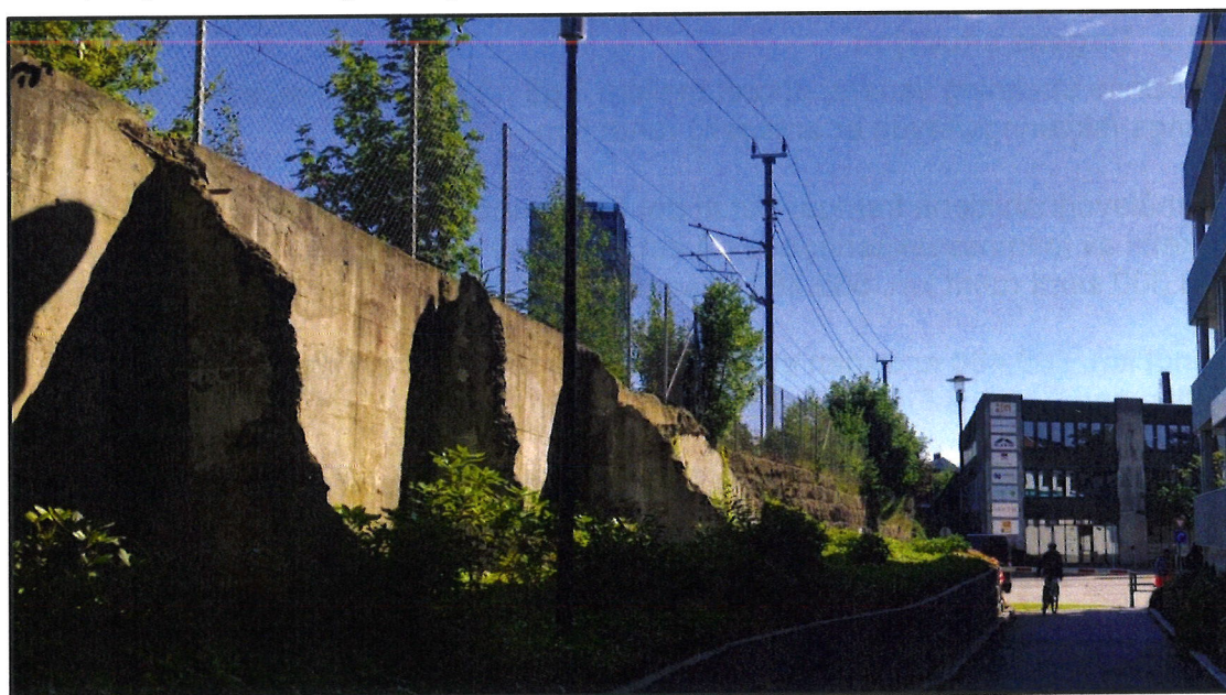
Figur 39 Dagens løsning med tørrmur/kjellervegg (km. 569,480). Bilde i sørlig retning. Kilde: Jakob Bitsch Jensen (befaring 2020-08-06).
