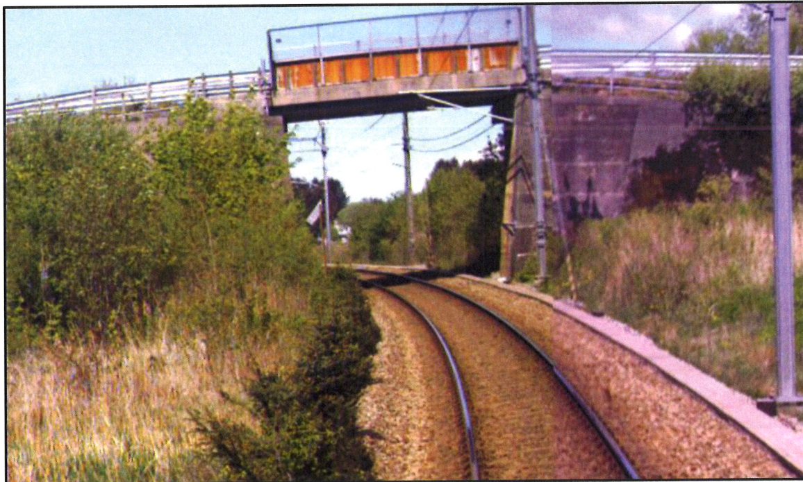
Figur 33 Konstruksjon ved dagens kryssing med Hognestadvegen (km. 565,708). Bilde i nordlig retning. Kilde: Målevognsbilde (fra Oslo).
