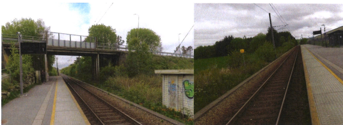
Figur 66 Bilde tatt på befaring som viser spor og stasjonsområdet på Øksnevadporten. Bilde til venstre viser Øksnevadporten holdeplass mot sør og høyre bilde viser retning nord.
