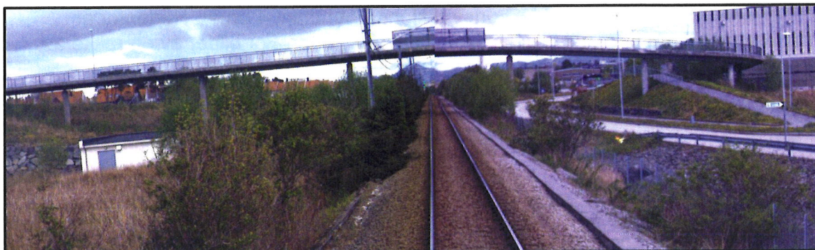
Figur 77 Konstruksjon ved kryssing med gang- og sykkelveg (579,516). Bilde i sørlig retning. Kilde: Målevogsbilde (mot Oslo).
