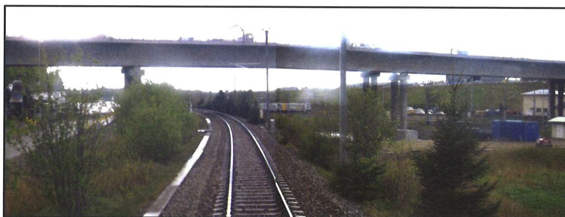
Figur 76 Konstruksjon ved dagens kryssing med Kvernelandsveien (km. 578,814). Bilde i sørlig retning. Kilde: Målevognsbilde (mot Oslo).
