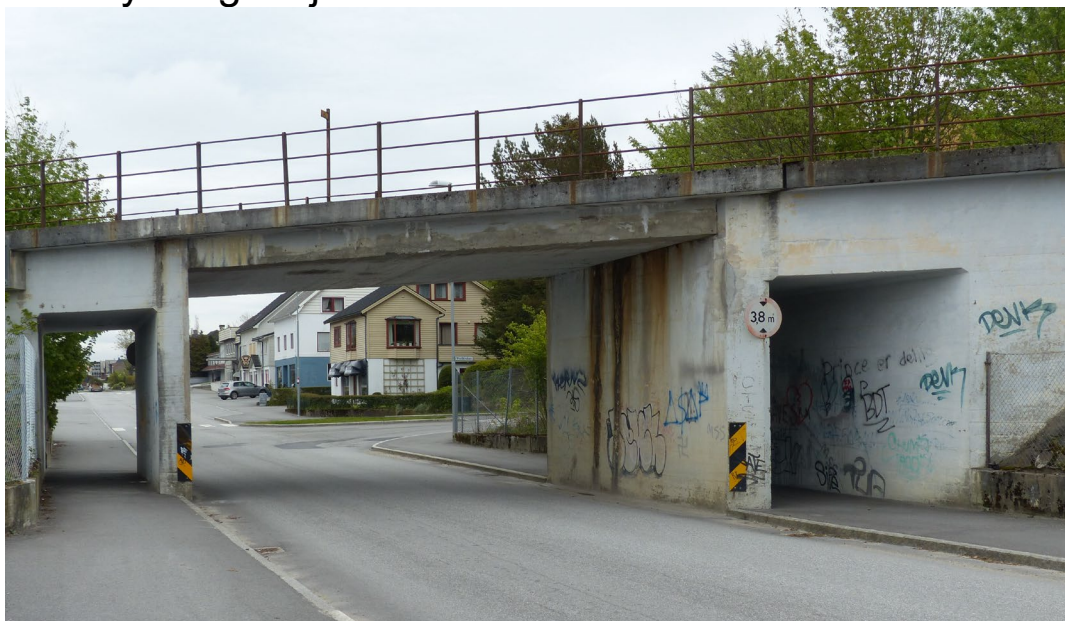
Figur 7-2 Opstadvegen på Nærbø er en av vegene som krysser under Jærbanen med høyderestriksjoner. Foto: Börje Karlsson.
