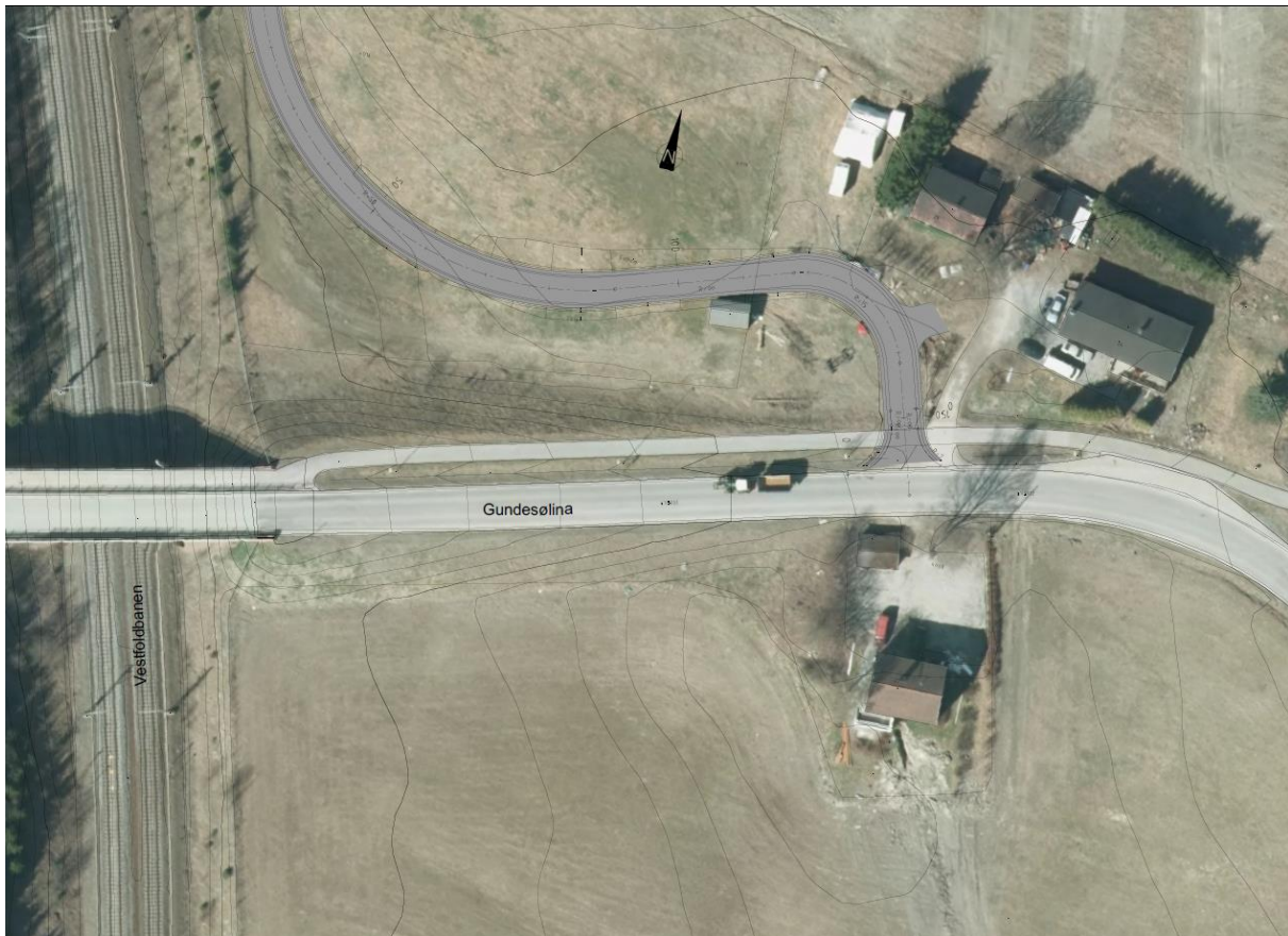
Figur 20: Anleggsvei fra Gundesølina, øst for brua
