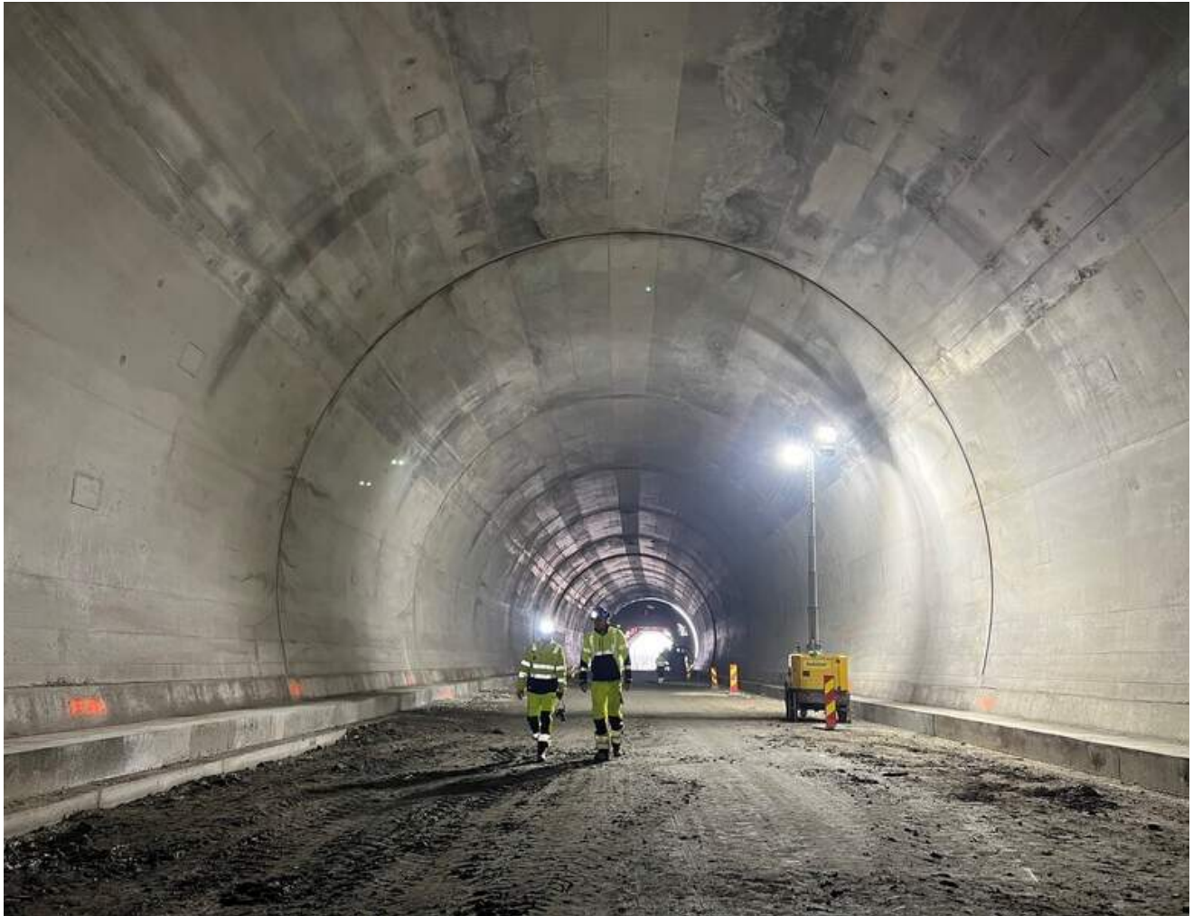
Tunnelen støpes i 12 meter lange seksjoner. Fremdriften er cirka én seksjon i døgnet. Portalen i Sandbukta ses i bakgrunnen. Foto: Øystein Stavdal Paulsen, Bane NOR.
