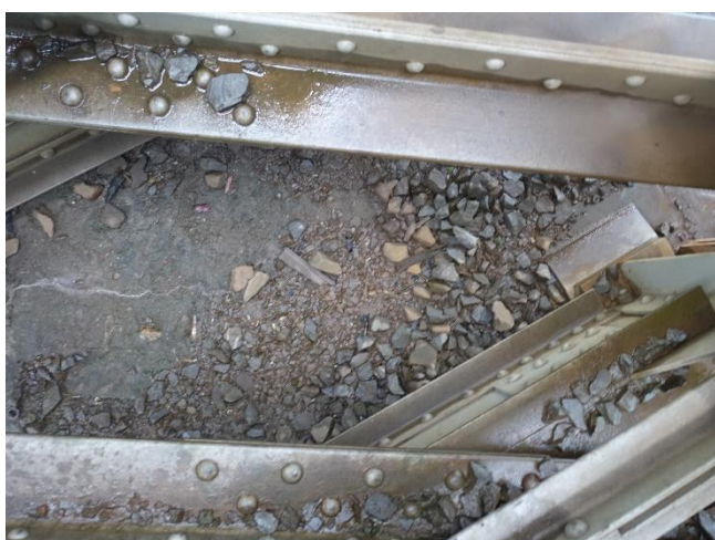
Foto nr. 11: Pilar akse 2.
