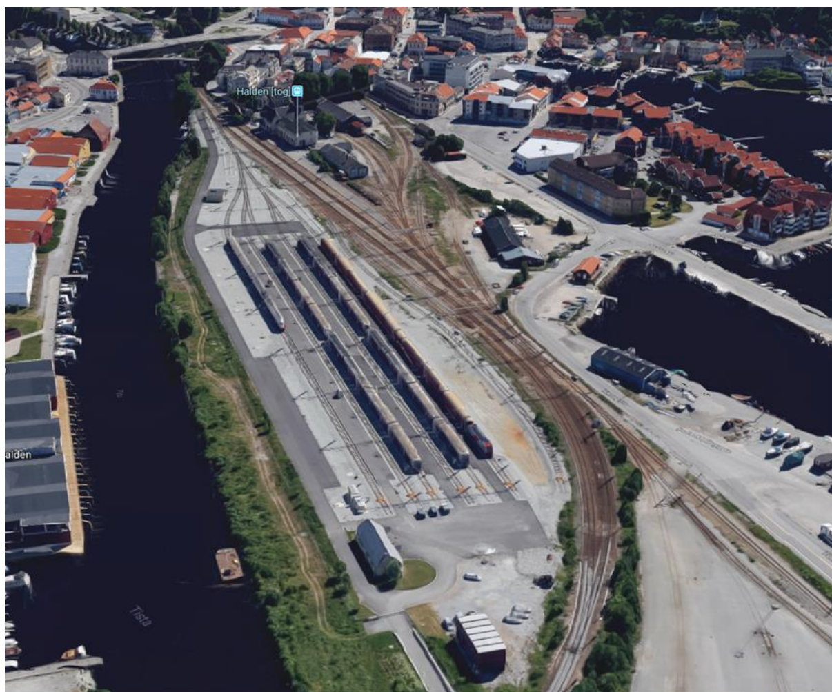
Figur 1 Illustrasjonen viser eksempel på et hensettingsanlegg - ved Halden stasjon. (Google maps)
