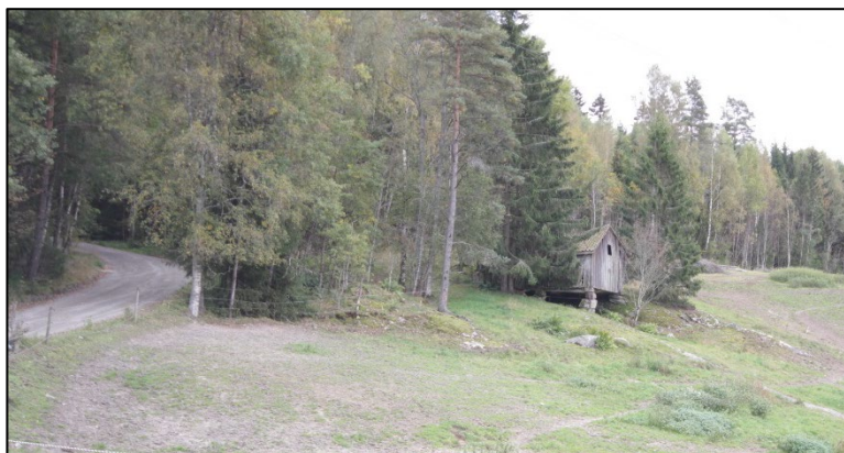
Figur 30 Stabburet som ble registrert på befaring.
