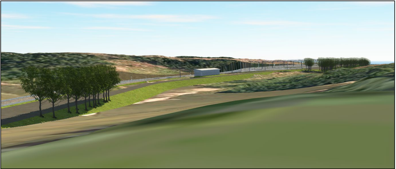
Figur 23 Sett fra området ved TUNET på Burum. Bildet viser teknisk bygg i forkant av sporvifta. Lenger bak vises sporvifta med fjellskjæring bak.
