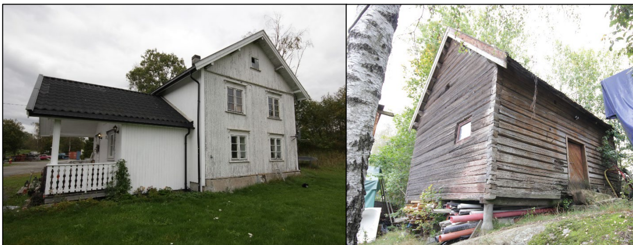
Figur 32 Bolighuset til venstre og stabburet til høyre. Begge er SEFRAK-registrerte bygninger.
