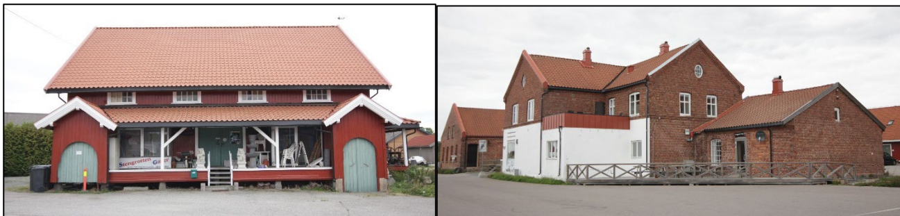
Figur 43 Stabbur handelslageret Rygge til venstre og handelslageret Rygge til høyre. Begge inngår i kulturmiljøet.
