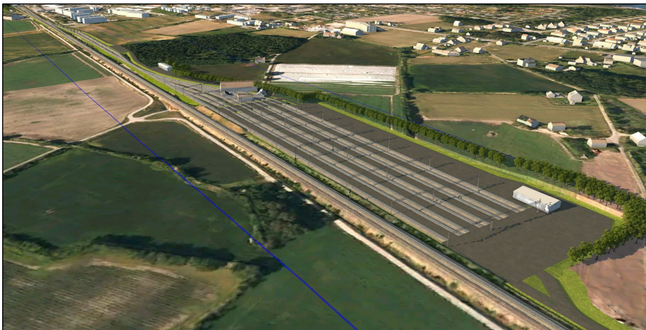
Figur 14 Oversikt over hensettingsanlegget sett fra sør. Adkomst via Eskelundvegen vises til høyre i bildet.
