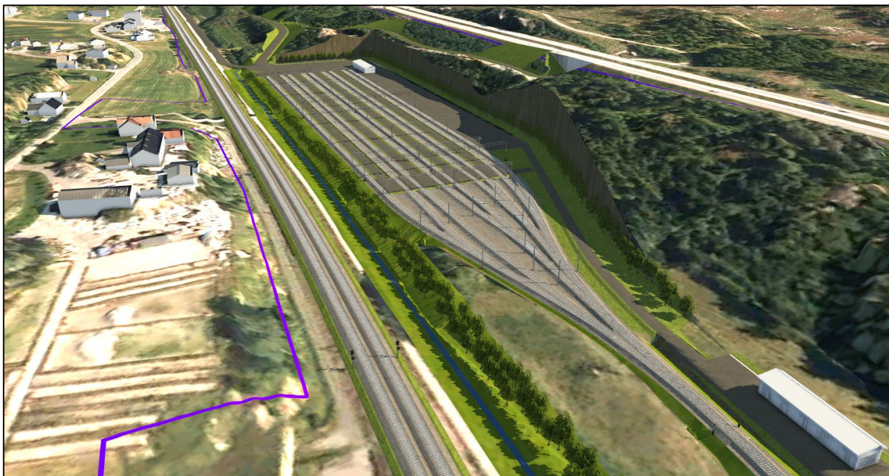
Figur 10 Selve hensettingsanlegget ligger med fjellskjæring mot øst (E6 i bakgrunnen). Mellom hovedsporet og hensettingsanlegget ligger Kambobekken som er lagt om. Til venstre tunet på Søndre Rød.
