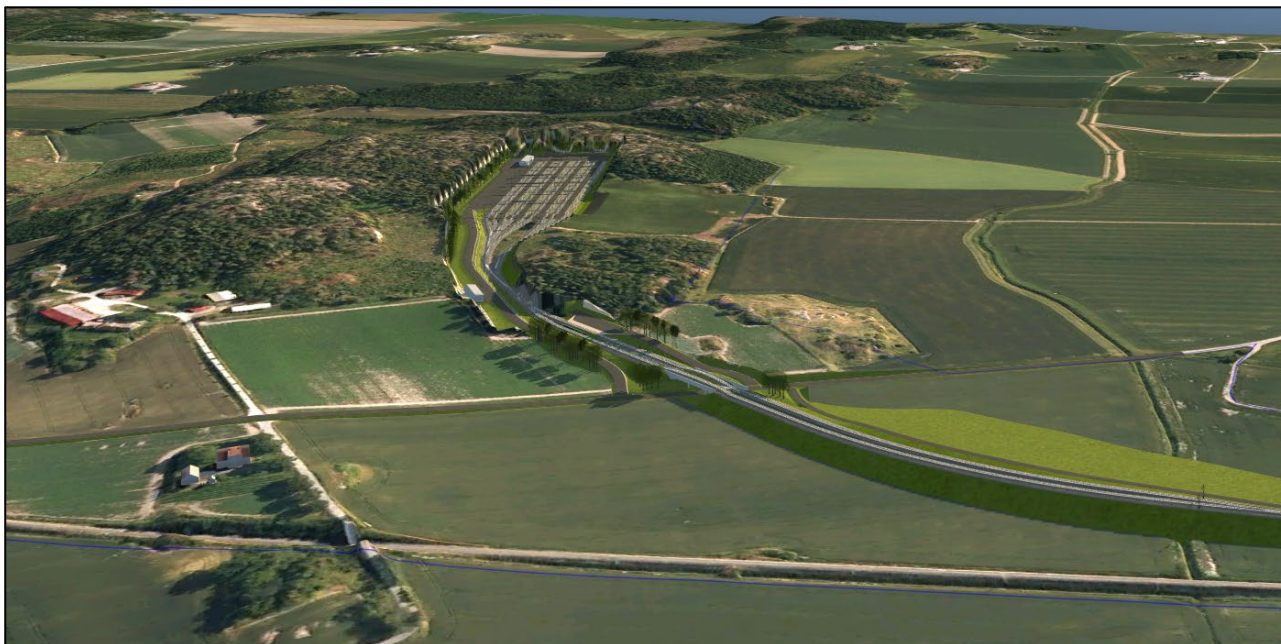
Figur 18 Oversiktsbilde fra nord viser at selve hensettingsanlegget ligger i skjæring, mens ankomstsporet ligger på fylling. Burum til venstre i bildet.
