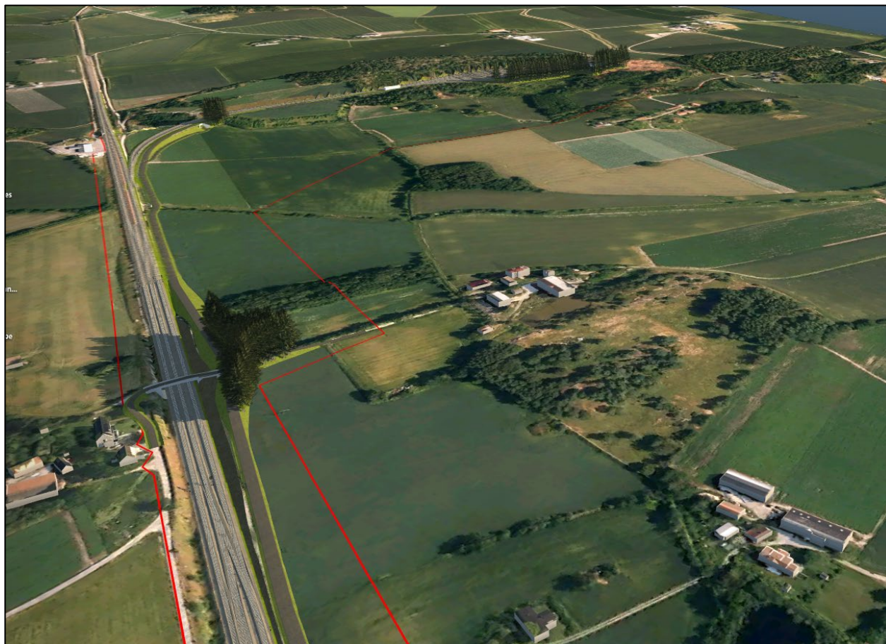
Figur 15 Oversiktsbilde fra nordvest viser ventespor og ankomstspor inn mot hensettingsområdet som ligger øverst i bildet. Adkomstvegen ligger langs høyre side av sporet.
