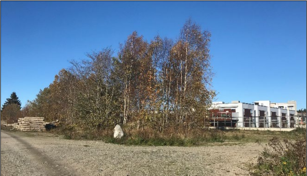
Figur 32 Ny boligbebyggelse ved Rygge stasjon
