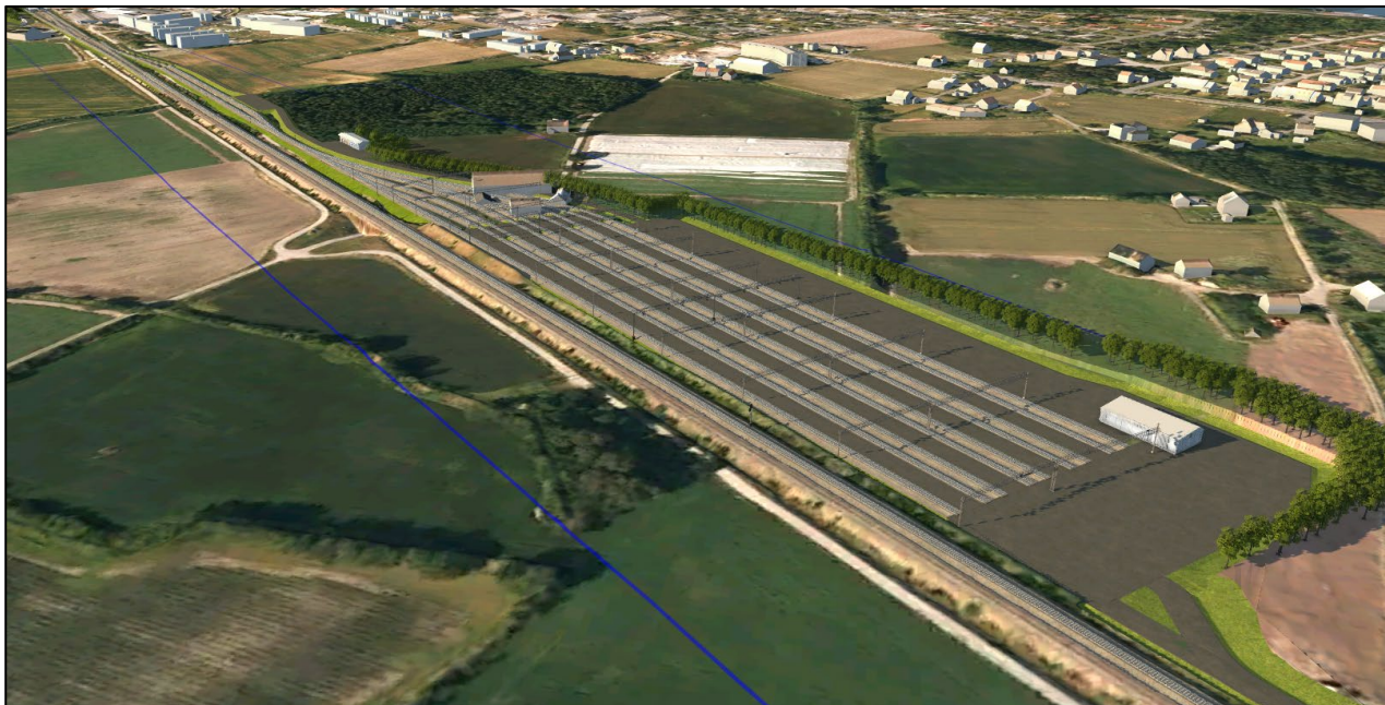
Figur 12 Oversikt over hensettingsanlegget sett fra sør. Adkomst via Eskelundvegen vises til høyre i bildet.
