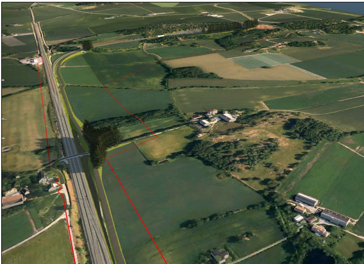
Figur 17 Oversiktsbilde fra nordvest viser ventespør og ankomstspor inn mot hensettingsområdet som ligger øverst i bildet. Adkomstvegen ligger langs høyre side av sporet.
