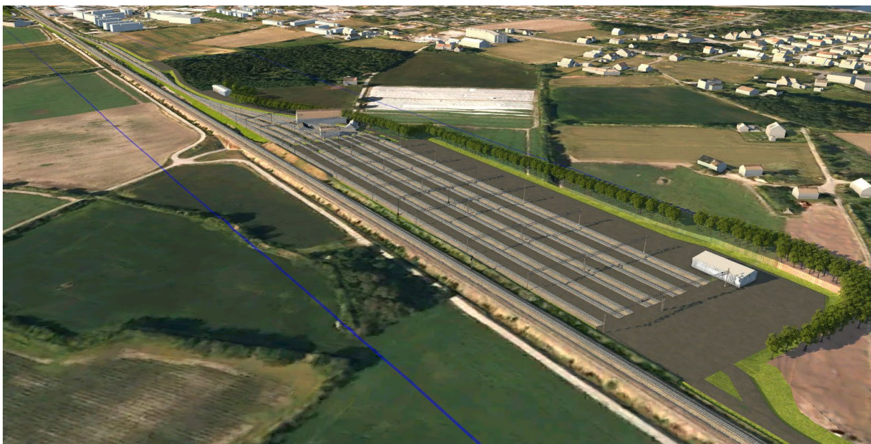
Figur 19 Sporområdet for hensetting blir liggende ved Gon gård. TUNET på Gon gård må innløses.
