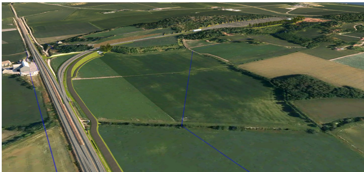
Figur 23 Oversiktsbilde av anlegget sett fra nordvest. Avgreningen fra hovedsporet vest for Løken.
