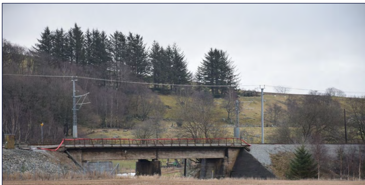
Figur 141: Eksisterende brukryssing over Figgjoelva. Konstruksjonen og fyllingene er dårlig tilpasset og fyllingene kun stedvis revegetert
