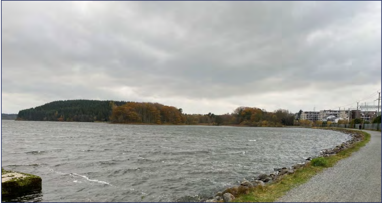
Figur 114: Sett fra nord langs vannet ved Klepp stasjon. Dette er det eneste stedet hvor det er en lengre sammenhengende fylling uten vegetasjon langs Frøylandsvatnet. Midt i bildet ligger en odde med bøkeskog, Ytreholmen
