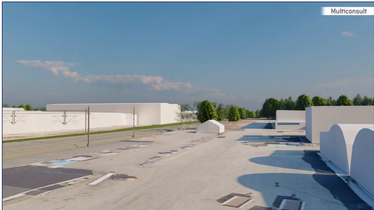
Figur 44: Transformasjonsområdet øst for jernbanen sett fra sørøst. Her med alternativ 1. Kontaktledningsmaster utenfor stasjonsområdene er ikke vist i modellen
