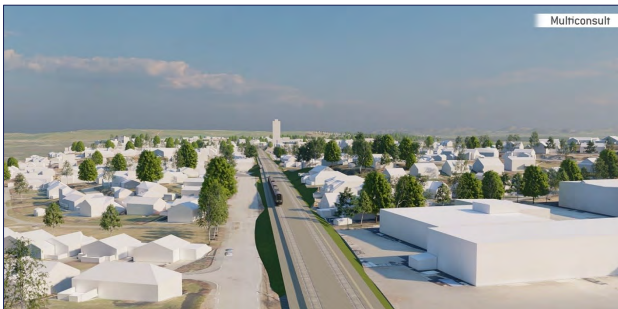
Figur 78: Boligområdet langs jernbanen sett fra sør med Alternativ 1. Kontaktledningsmaster og eventuelle støytiltak og støttekonstruksjoner er ikke vist i modellen
