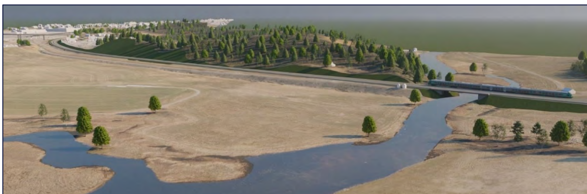
Figur 144: Eksisterende jernbanelkryssing er i eksisterende situasjon ikke godt tilpasset landskapet og en dobling av bredden vil gjøre kryssingen noe mer dominerende lokalt. På lengre avstand, som her fra Elisberget, vil imidlertid kryssingen ikke fremstå som dominerende i landskapet. Kontaktledningsmaster og eventuelle støyttiltak og støttekonstruksjoner er ikke vist i modellen
