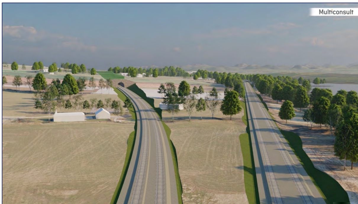
Figur 105: Jordbrukslandskapet nord for Nærbø der alternativ 2 går inn i tunnel, mens alternativ 1 følger eksisterende jernbane. Kontaktledningsmaster og eventuelle støytak og støttekonstruksjoner er ikke vist i modellen
