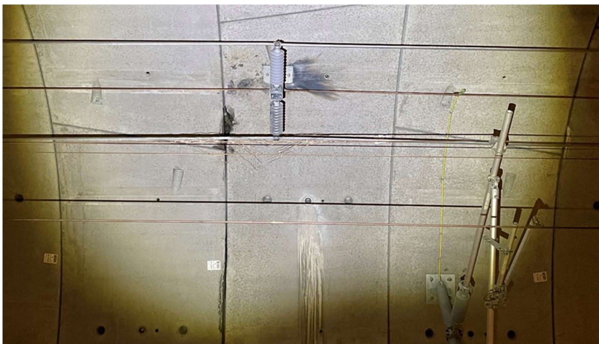
Figur 11 Kortslutningssted ved hengemast F-022-09. Retning Ski til venstre og retning Oslo til høyre.
