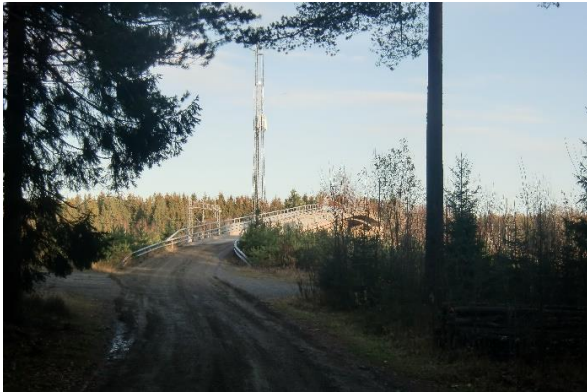
Først selve Sandsbrua som må rives
