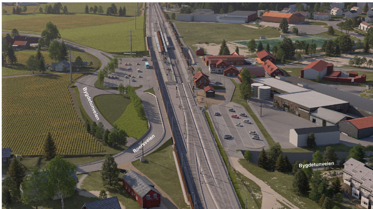
Figur 30 Oversikt over veg- og parkering sørvest for stasjonen, med Gate gård i forgrunnen. Fortau langs Roersveien, mellom parkeringsplassen og jernbanen er vist i figuren.
