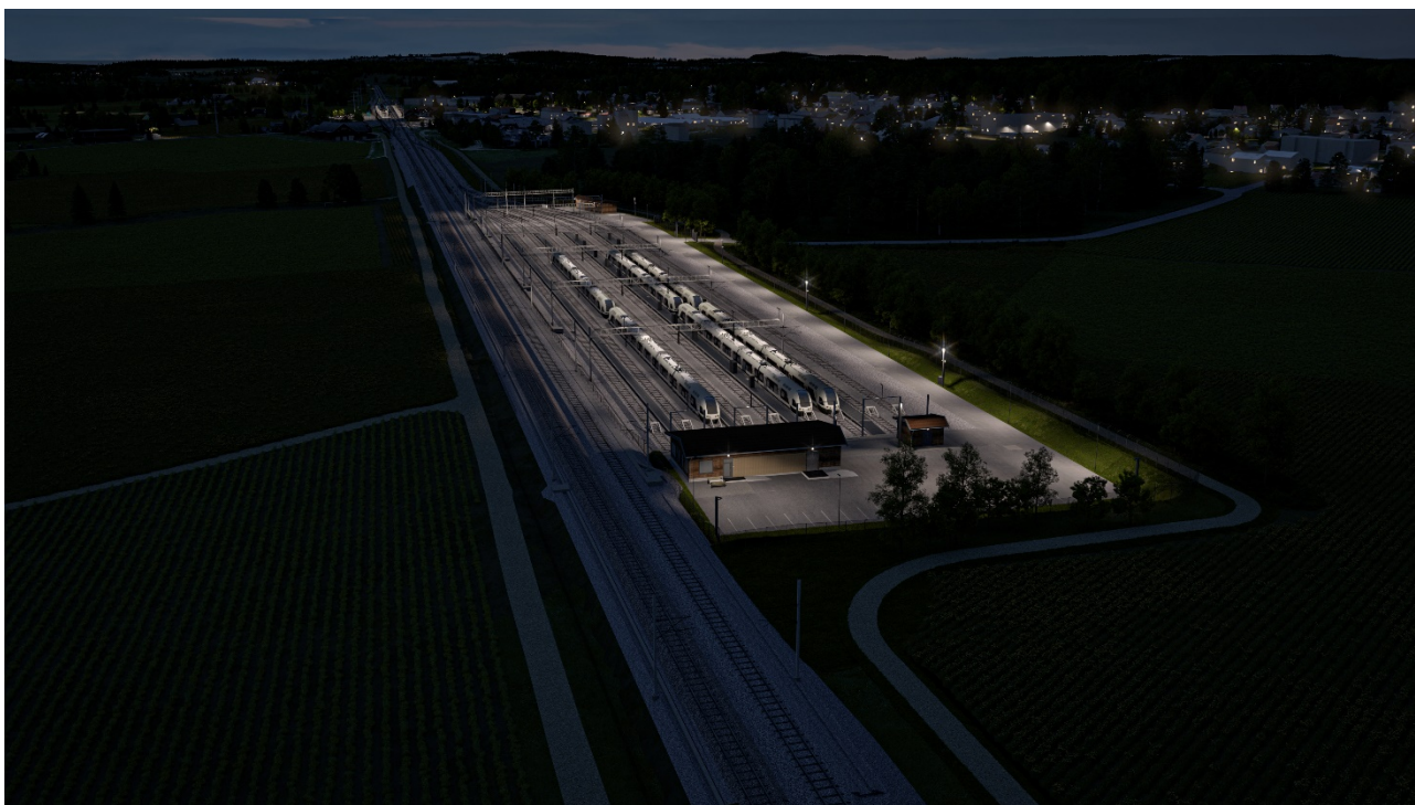
Figur 27 Oversiktsbilde over hensettingsanlegget sett fra sørøst - nattbilde. Bildet gir et inntrykk av lysspredningen fra anlegget med den planlagte belysningen. Bruk av avskjermede armaturer skal redusere spredningen av lys til omgivelsene.
