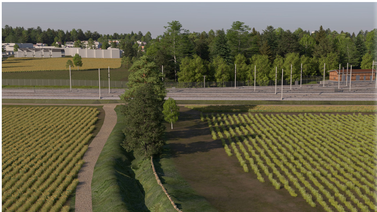
Figur 19 Vestre hjørne av Gonskogen sett fra vestsida av sporet ved Gatubekken. Bekken føres under sporet i ny kulvert. Det etableres en forsenking i terrenget på østsida av sporet for å lede og fordøye overvann før det går inn i kulverten. I denne området retableres vegetasjon for å bedre skjermingen mot anlegget. Vegetasjonen vil være mindre når den er nyetablert.
