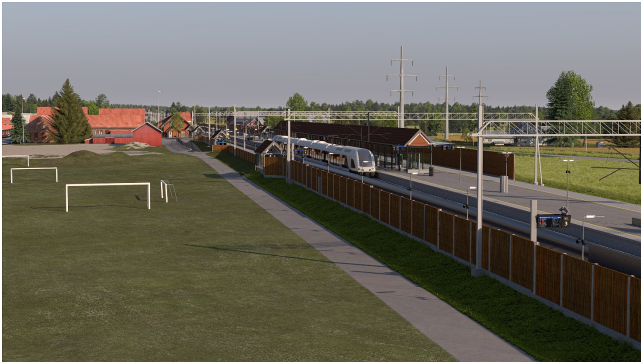
Figur 9 Oversiktsbilde over stasjonen, standpunkt over idrettsanlegget, sett mot sørøst. Midtplattform med takoverbygg over rampe opp fra undergangen sentralt i bildet.
