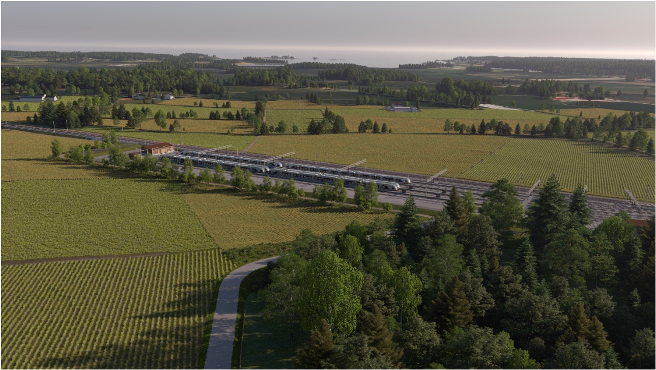
Figur 18 Hensettingsanlegget sett fra Gonsgrinda, oversiktsbilde fra høyden. Vegetasjonsskjermen vil bidra til å dempe visuelle virkninger i det åpne kulturlandskapet.
