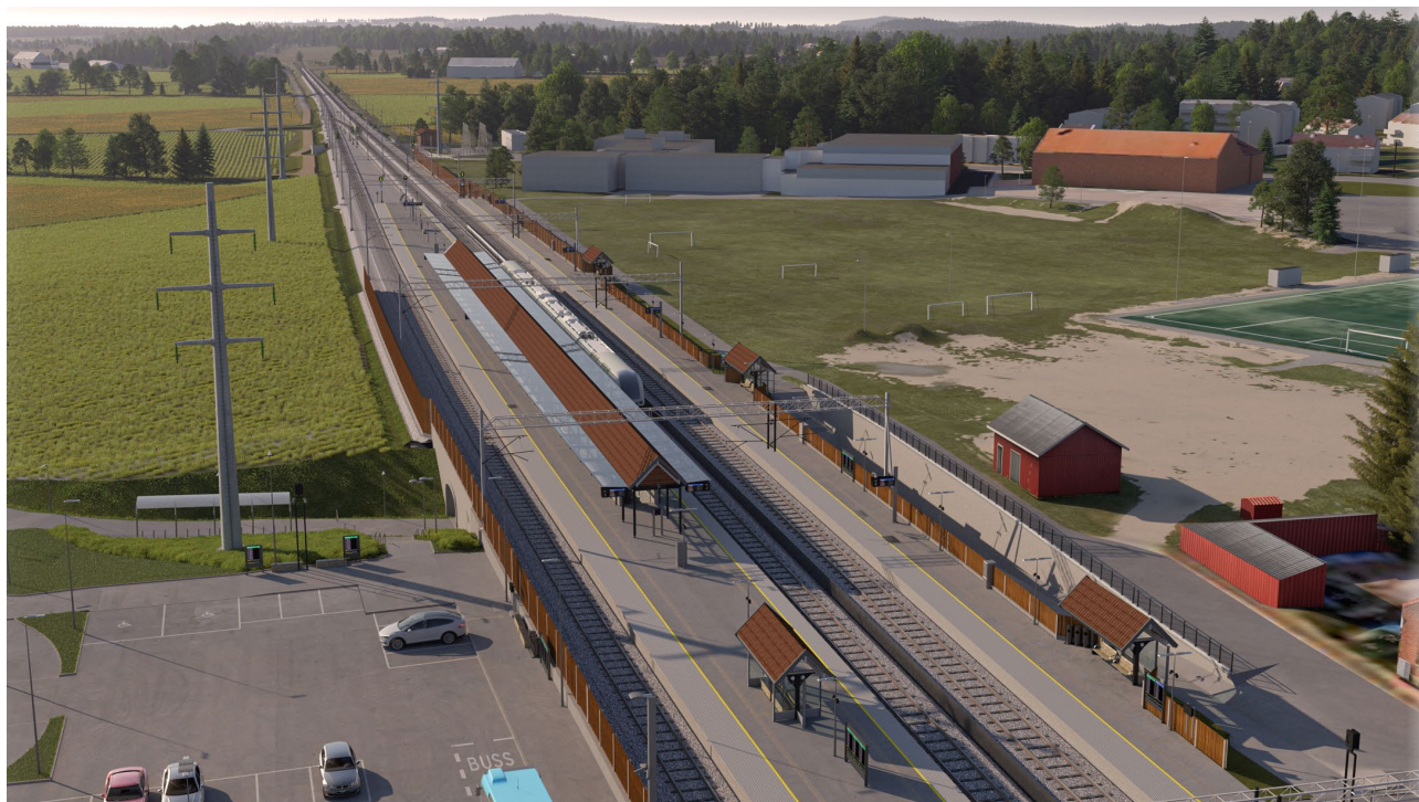
Figur 1 Oversiktsbilde fra stasjonsområde mot nordvest, retning Moss
