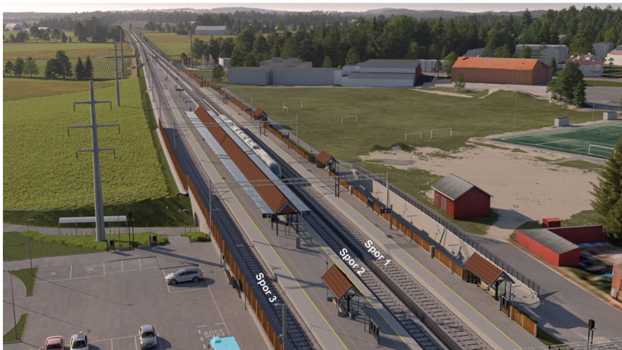
Figur 8 Oversiktsbilde fra stasjonsområde mot nordvest, retning Moss
