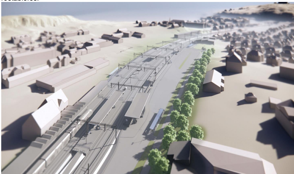
Figur 4-5: Stasjonsområdet sett mot nordvest, østre og midtre plattform med plattformtak. Helt til venstre vises areal for sykkelparkering under tak.
