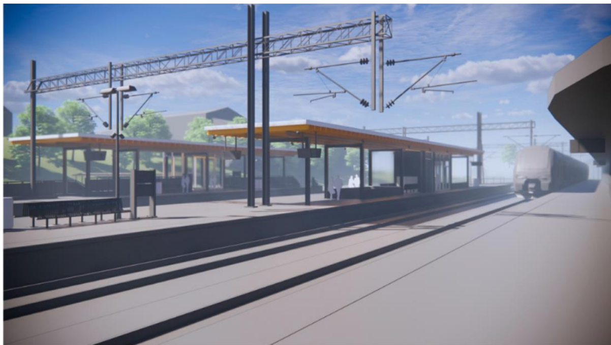
Figur 4-3: Østre plattform (til venstre i bilde) og midtre plattform sett mot sørøst. Plattformtak skjermer heishus og trappeløp.
