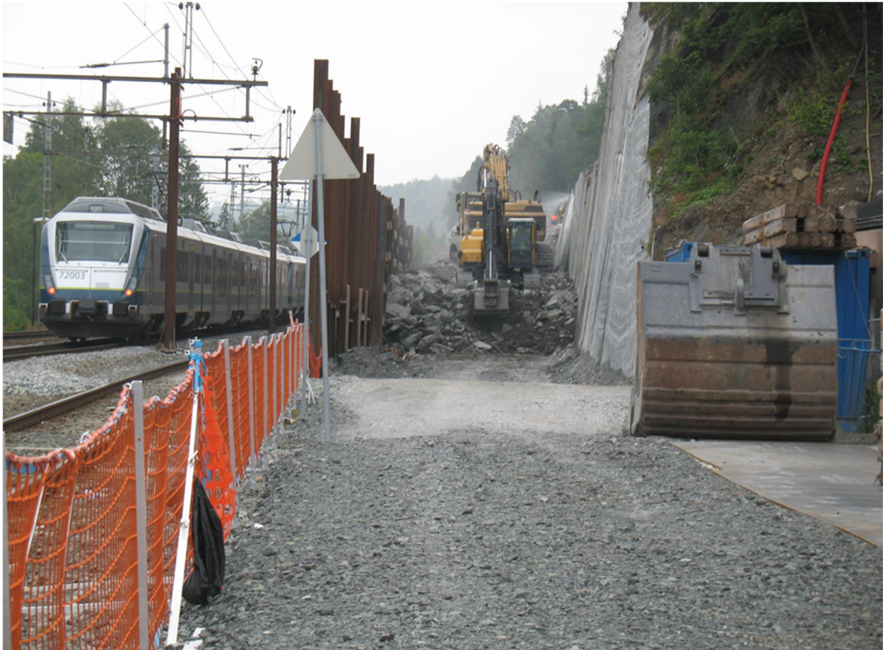
Figur 4-2: Eksempel på sikrings skjerm mot jernbane i drift. Berguttak ved hjelp av wiresaging og pigging langs Engervannet på strekningen mellom Lysaker og Sandvika
