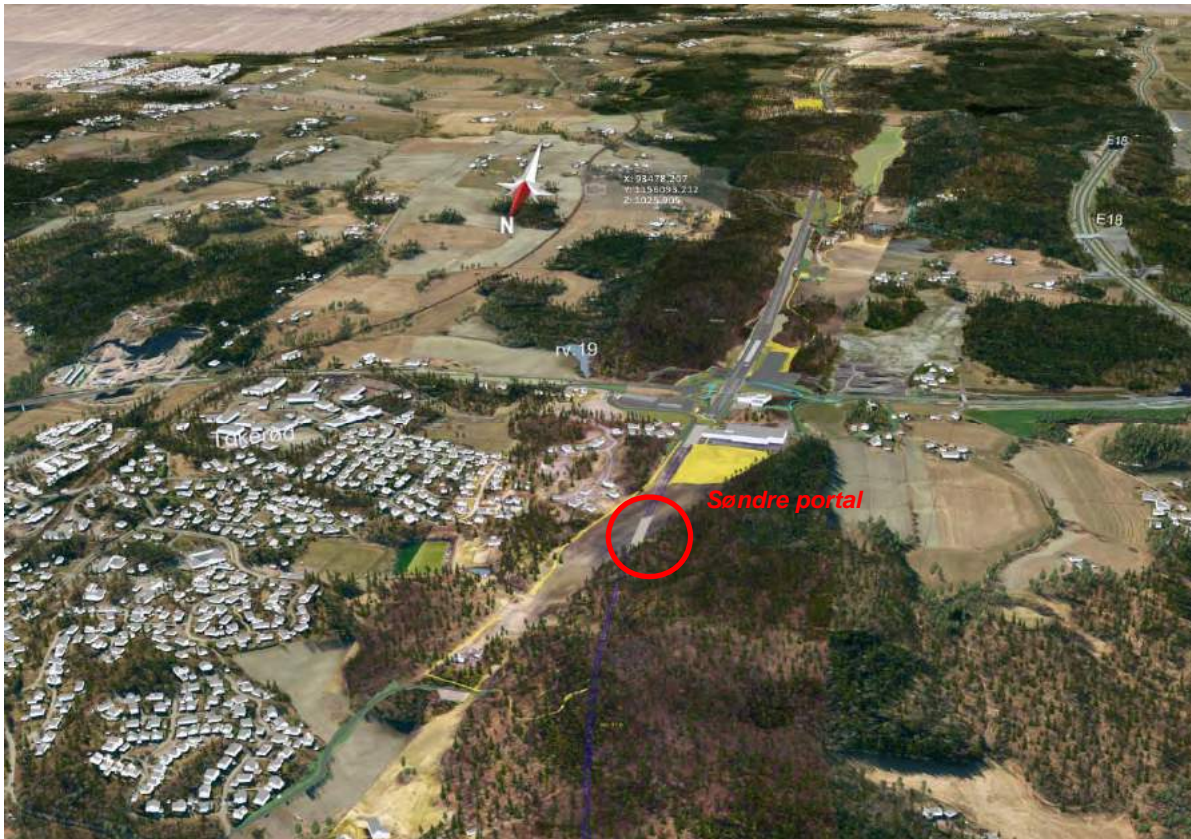
Figur 8-2. Oversiktsbilde over søndre portal på km 98,0 der rød sirkel er plassert (overgang berg- til betongtunnel).
