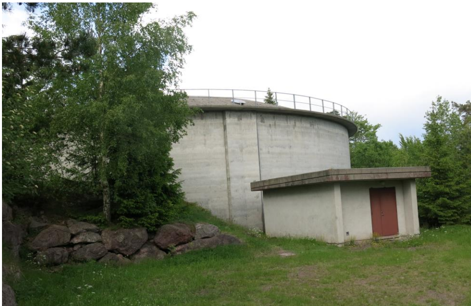
Figur 10-1: Skottås høydebasseng beliggende mellom km. 96,100 – 96,150 over Skottåstunnelen. Ventilrommet i forgrunnen, bassenget bak.
