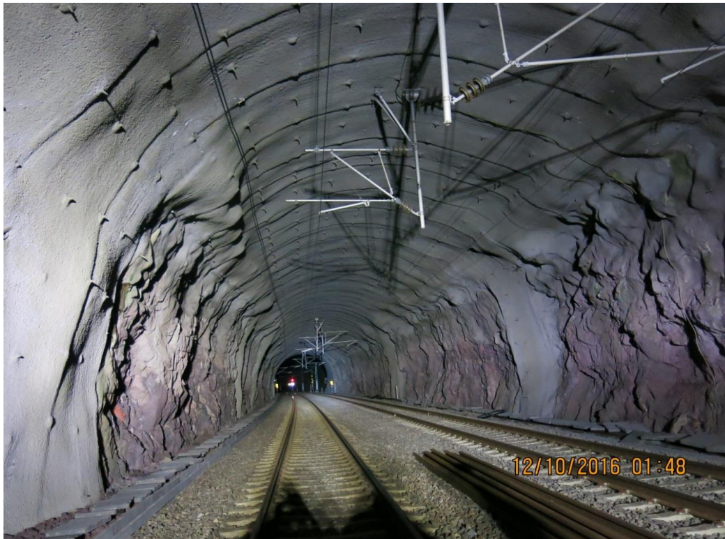
Figur 2-1 Tangenttunnelen ved Nykirke sett fra nord mot sør. Vann- og frostsikring i hengen, og nedføring av vann lokalt i veggene.
