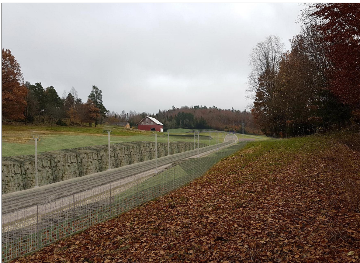
Figur 45. Tiltaket sett sørover mot Skaug og påhugg Skottåstunnelen.
