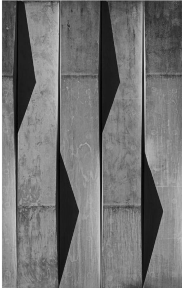
Eksempel på betong matrise støp
