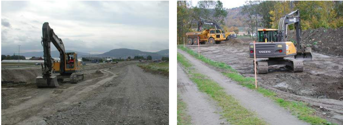
Figur 7-2: a. Oppbygd anleggsvei i jordbruksområde i Lier (til venstre) og b. Driftsvei for landbruksmaskiner benyttet til anleggstrafikk (til høyre)
