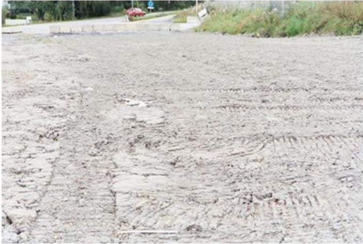
Figur 7-3: Planering av undergrunnsleire under våte forhold med bulldoser gir stor spordekning og komprimering til stor dybde (Foto: Trond Knapp Haraldsen)
