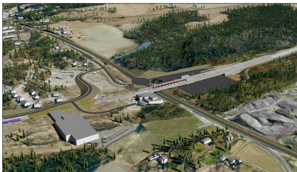
Figur 6-2: Stasjon på Skoppum vest sett mot øst
