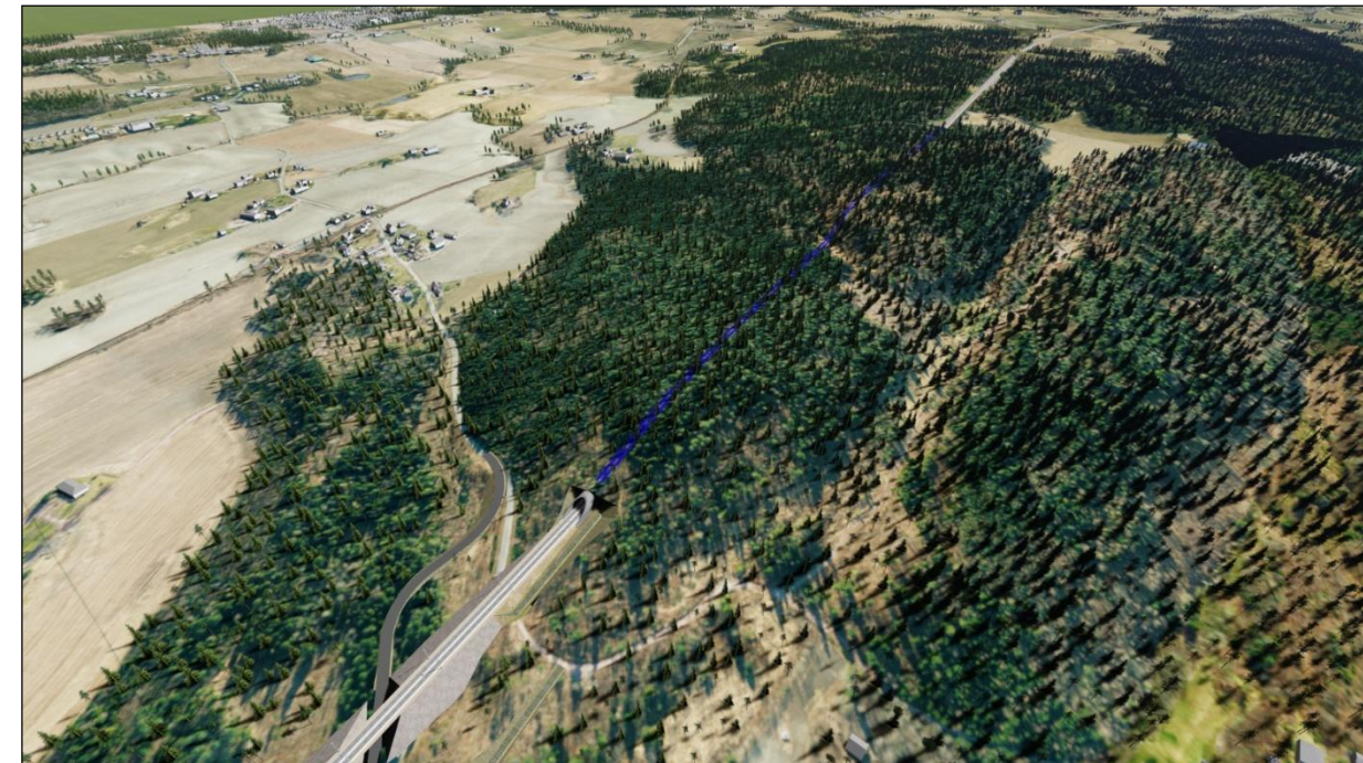
Figur 4-2: Strekningen gjennom Tangsrødmarka mot Barkåker sett mot sørøst
