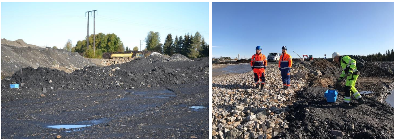
Figur 12: Bildene viser masselageret til Skanska ifm. Veiprojektet Rv.3/25 (venstre). Bildet til høyre viser hvor massene fra veiskråningen ved Myklegard er hentet. (Venstre foto: Trond Knapp Haraldsen. Høyre foto: Marius Tevik Olsen)
