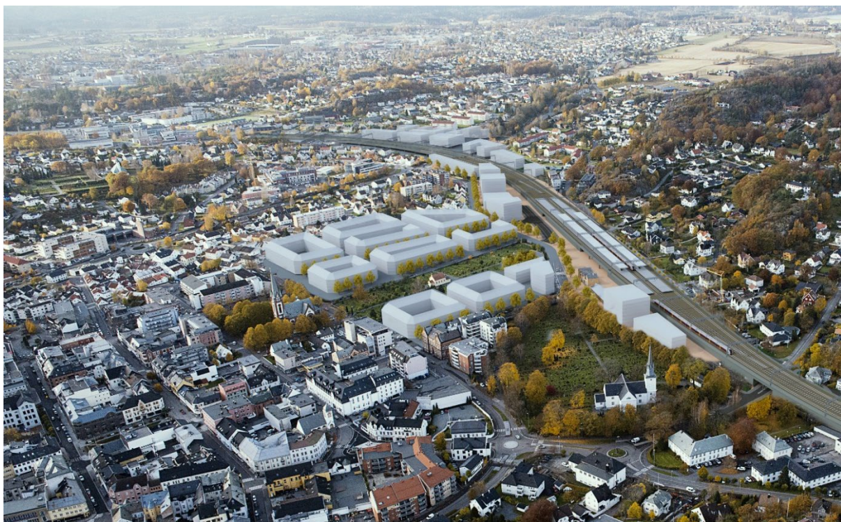
Figur 1-4: Muligheter for byutvikling ved Sandefjord stasjon i Gokstadkorridoren. Kilde: Stasjonsmodeller for Sandefjord stasjon utarbeidet av NOAV for Bane NOR.
