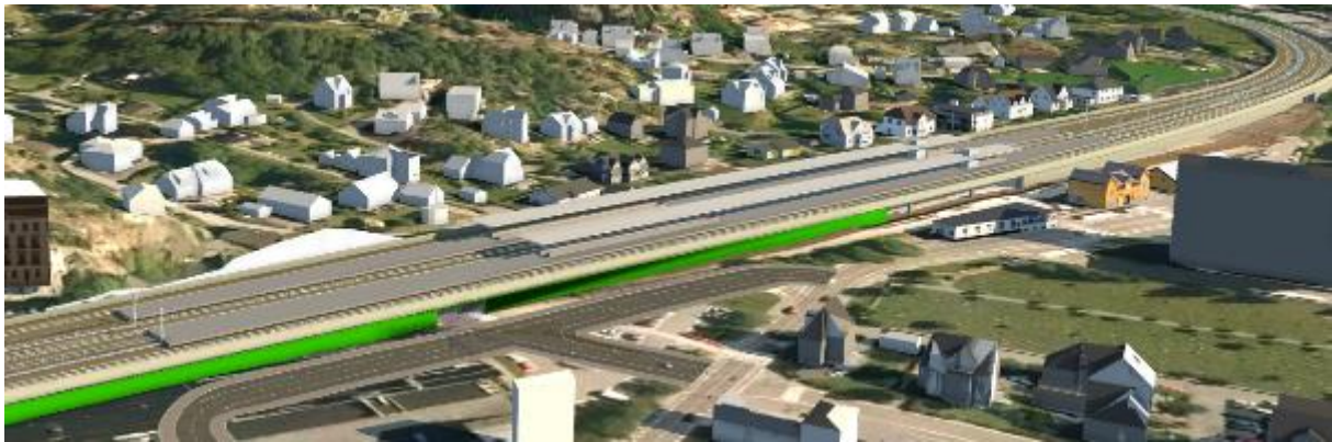
Figur 2-8 Sandefjord stasjon i Gokstadkorridoren, sett fra sørvest, retning Larvik mot venstre.
