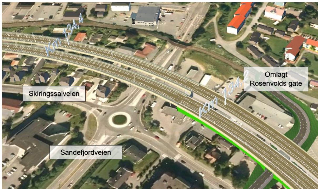
Figur 5-8 Kryssing over Sandefjordsveien. Dagens jernbane sees noe lenger nord. Sett fra sør, retning mot Larvik til venstre i bildet.
