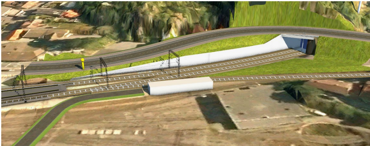
Figur 5-20: Støttemur mellom veg og bane mellom stasjonen og portalåpningen. Storgata legges om over betongtaket. Sett fra sør.
