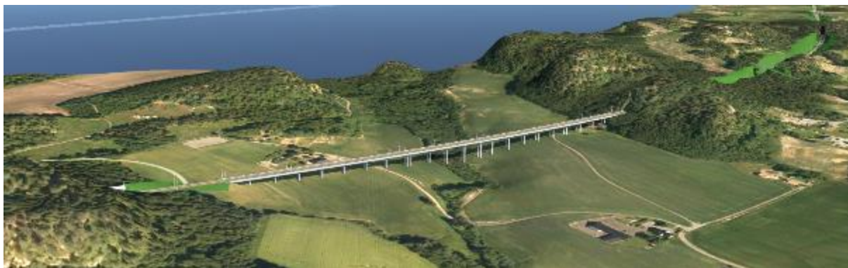
Figur 2-2 Linja i Torp vest-korridoren med åpen skjæring gjennom Stangeskogen og lang bru over Unnebergdalen. Sett fra sørøst mot nordvest, Sandefjord er mot venstre i bildet.
