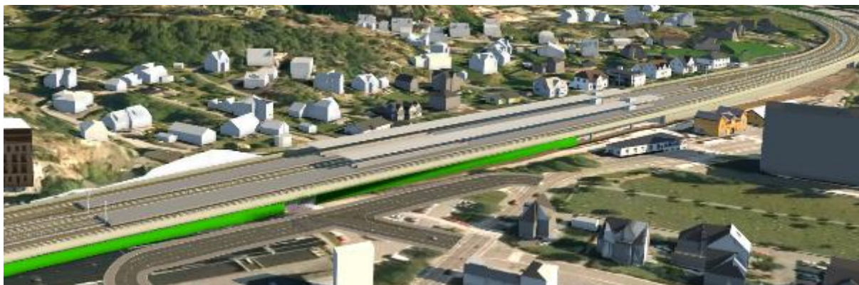
Figur 2-6 Sandefjord stasjon i Gokstadkorridoren, sett fra sørvest.
