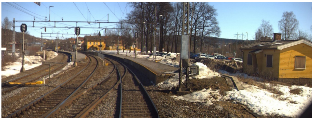
Figur 1-3 Stasjonsområdet sett mot nord. Parkeringsplass for reisende ligger til høyre i bildet.
