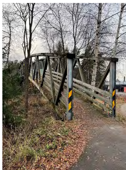
Figur 6-94: Gangveg langs Skogvegen (Foto: Bane NOR).
