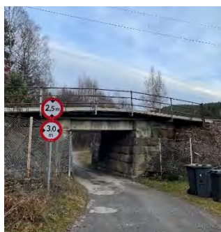
Figur 6-77: Ekredalsvegen med kulvert (Foto: Bane NOR).
