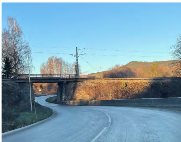
Figur 6-25: Skansvegen under jernbanen. (foto: Bane NOR).
