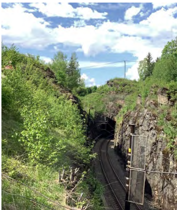
Figur 6-73: Tunnellokk ved Skarpsno (Foto: Bane NOR).
