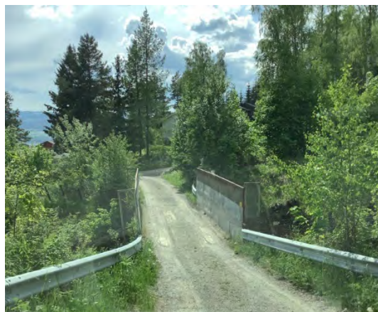
Figur 6-67: Skarpsnovegen, kryssingspunkt over jernbanen (Foto: Bane NOR).
