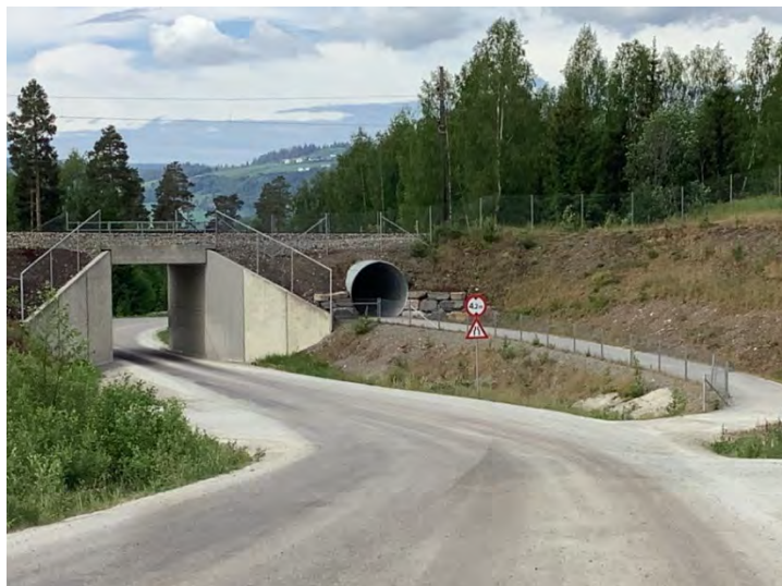
Figur 6-72: Kulvert i Røsslyngvegen, som også er krysningpunkt for skispore (Foto: Bane NOR).
