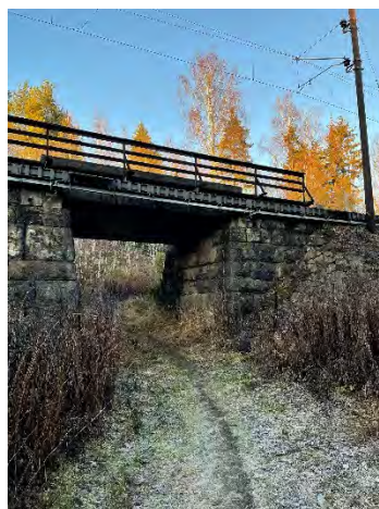
Figur 6-26: Kulvert med turveg som knytter sammen Fremstadvegen og Ringsakervegen. (foto: Bane NOR).
