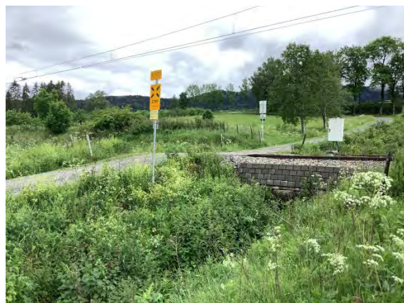
Figur 6-99: Adkomstveg til Nedre Veia gård med planovergang (Foto: Bane NOR).
