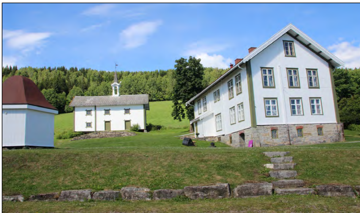
Figur 6-70: Føderådsbygningen og stabburet på Simenstad. På tunet ser vi også brønnhuset fra 2003. Foto: Hedmark fylkeskommune, Anno Domkirkeodden.
