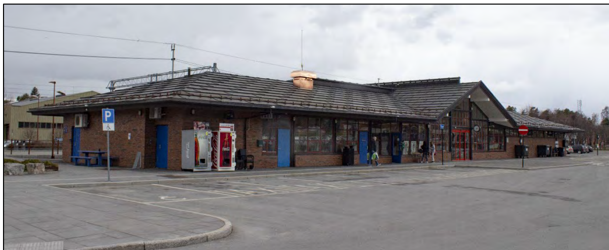
Figur 6-128: Dagens stasjonsbygning har fremdeles skråtak på midten, men likner ellers lite på den opprinnelige bygningen. Foto: Jan Adriansen, Rambøll Sweco.
