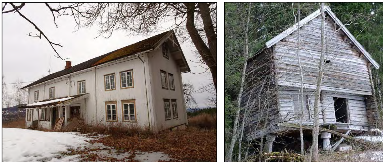
Figur 6-14: Til venstre hovedhuset og til høyre stabburet på Kokkine, begge trolig fra 1700-tallet. Kilde og foto: Agnethe Jovall, Innlandet fylkeskommune.
