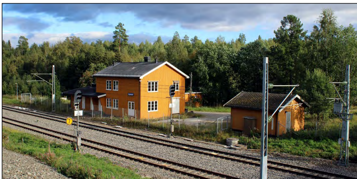
Figur 6-62: Rudshøgda stasjon. Foto: Jan Adriansen, Rambøll Sweco.
