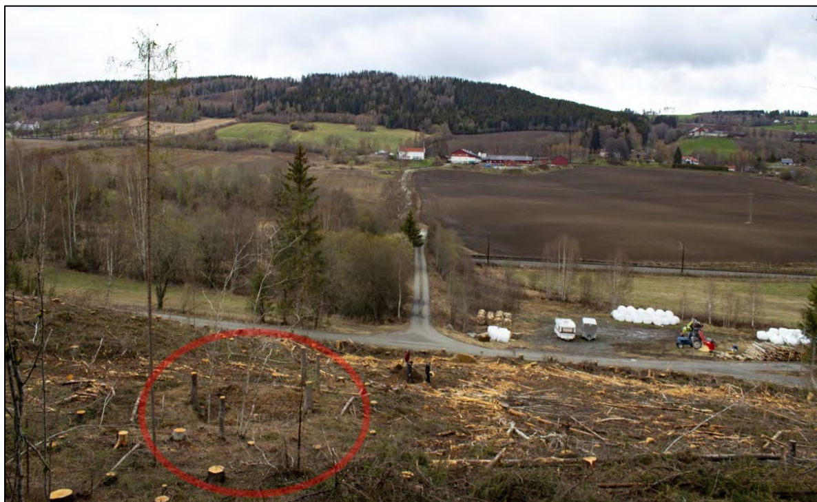
Figur 6-58: En av kullgrope (Askeladden-ID 120316) innenfor det definerte kulturmiljøet ligger rett i kanten av alternativ A-B og B ovenfor KM 23 Prestvegen ved KM 20 Husmannsplassen Pålsrud. Foto: Jan Adriansen, Rambøll Sweco.
