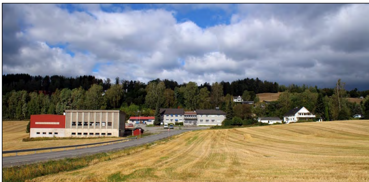
Figur 6-99: Ringsaker og Nes Kraftanlæg (R.N.K). Foto: Jan Adriansen, Rambøll Sweco.
