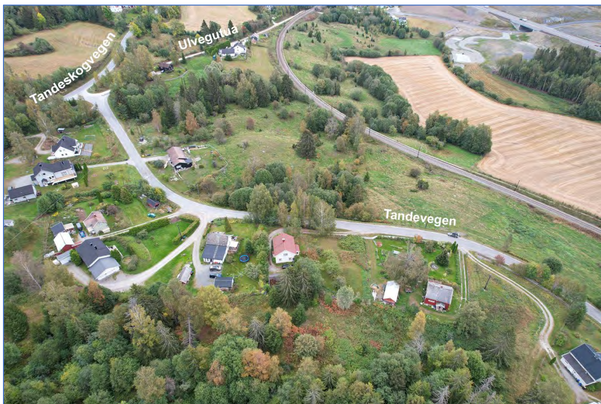
Figur 6-91: KM 34 sett fra drone. Foto: Rambøll Sweco.
