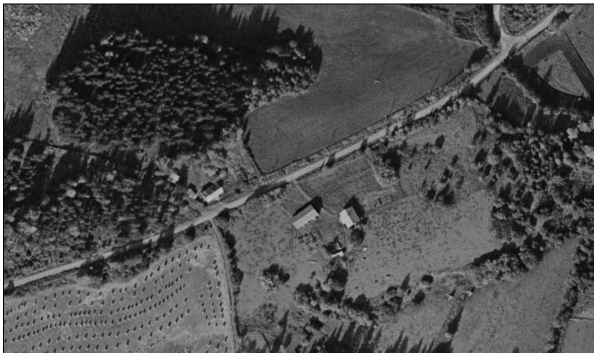
Figur 6-11: På flyfoto fra 1956 ser vi husene som fantes innenfor kulturmiljøet på hver side av vegen. Kilde: Geodata.no.
