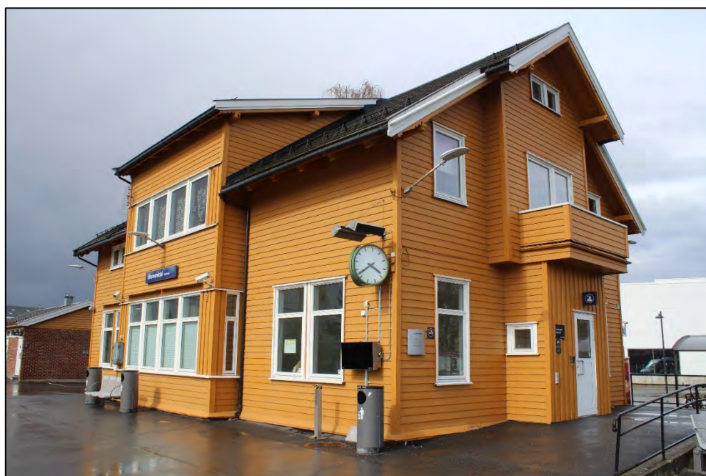
Figur 6-8: Stasjonsbygningen på Brumunddal stasjon fra 1894. Foto: Jan Adriansen, Rambøll Sweco.
