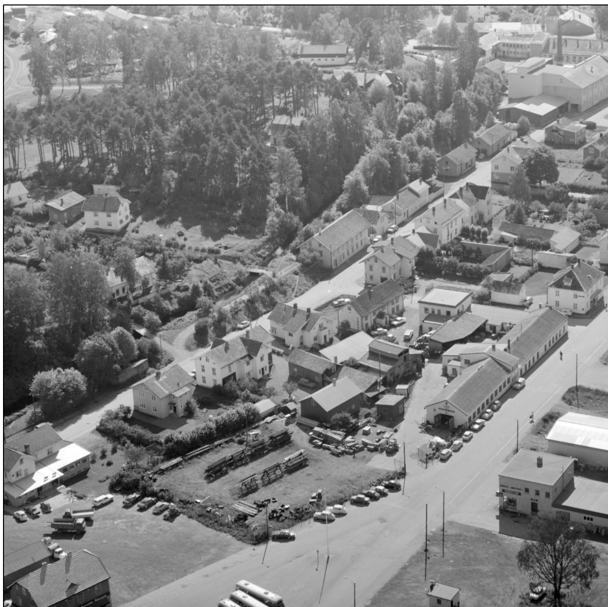
Figur 6-5: På 1970- tallet ble Kvernveita delvis fylt igjen, mens andre deler grodde igjen. I Gamlegata er en strekning av veita åpnet og tilrettelagt som et kulturminne. Fotografiet viser Gamlegata i 1970, før Kvernveita til venstre for Gamlegata ble fylt igjen. Foto: Magne Lilleøen, Anno Domkirkeodden.
