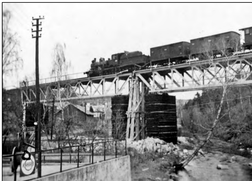
Figur 6-130: Moelven bru midlertidig reparert i 1940 etter å ha blitt sprengt. Foto: Håkon Prestkværn. Anno Domkirkeodden.
