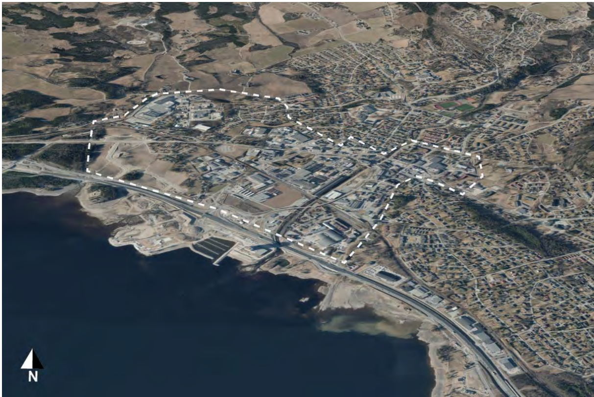
Figur 6-6: Flyfoto som viser LB 01 Brumunddal sentrum.
