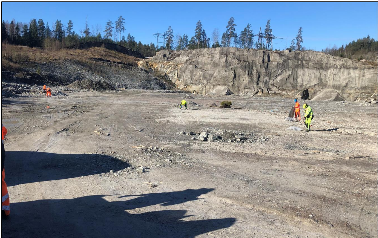
Figur 3. Bilde som viser dagens situasjon ved «Low Area» tatt av entreprenør Hæhre Isachsen 26.04.23. Hauger i bakgrunnen er tetning mot tunnelåpninger.
