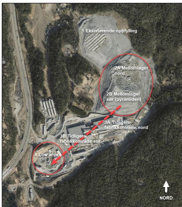
Figur 7. Flyfoto fra 2020. Masseforflytning på anleggsområdet er omtrentlig skissert. Masser som er lagret i område 2A og B (bl.a. pyramiden) skal flyttes til område 4 Low area.
